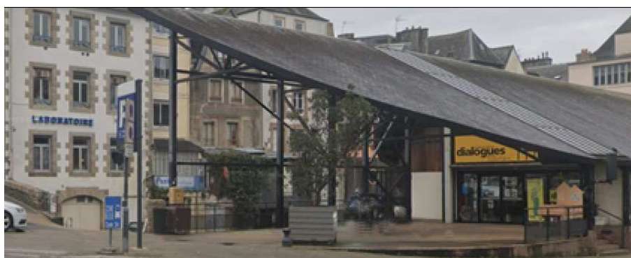
Le bon auvent qui protège de la pluie.... si elle tombe tout droit
