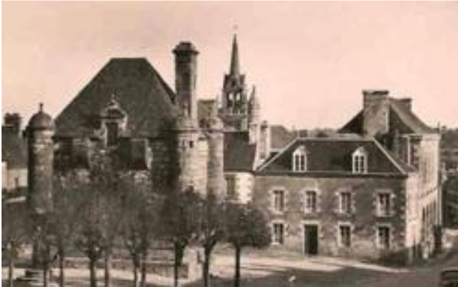
Le pignon de la maison construite est toujours aligné avec la façade au midi du bâtiment qui a remplacé la Halle aux viandes.
