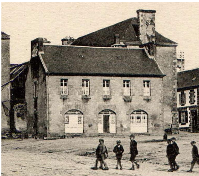
Maison d'Augustin-Marie Herland au début du XXe siècle. Le porche qui en son milieu permettait initialement d'accéder à la cour entre les halles a été supprimé.
